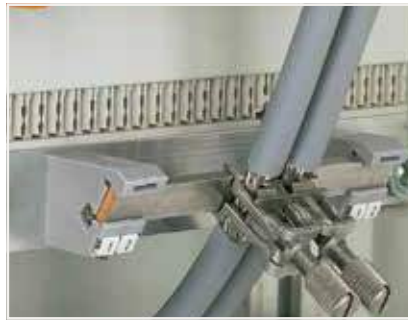
Ortak koruma refesans potansiyeli için yalıtımlı montaj taşıyıcıları (790-100)
