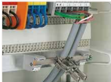
2 yalıtımlı taşıyıcı (790-100) üzerinde ortak potansiyelli ekranlama modülleri
