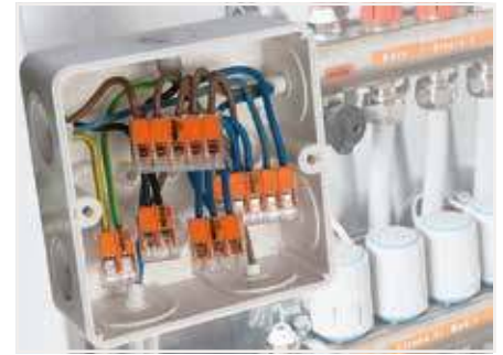
İnce telli iletkenlerin bağlantı kutularında kablolanması
