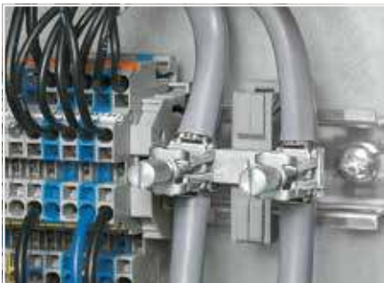
1 DIN rayına paralel topraklama ayaklı taşıyıcı
